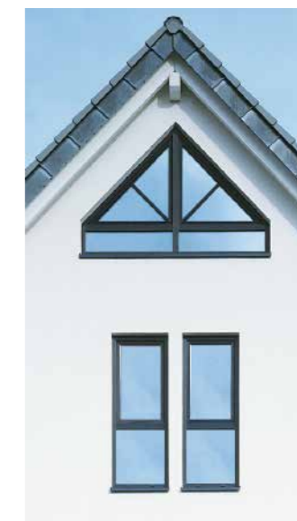
Des petits-bois placés horizontalement soutiennent l'axe horizontal et donnent l'impression d'élargir la vue.
