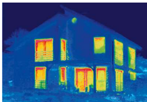
Zdjęcia termowizyjne wyraźnie pokazują, w których miejscach energia ucieka z domu w sposób niekontrolowany. Czerwona barwa oznacza wysokie straty ciepła.
