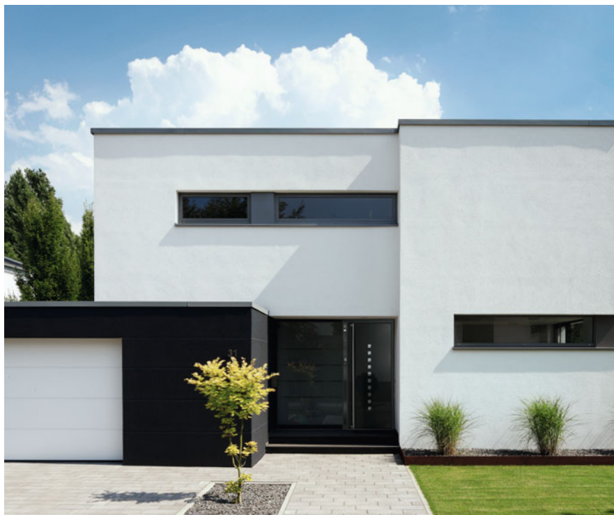
W nowoczesnych drzwiach wejściowych technika nie jest widoczna
